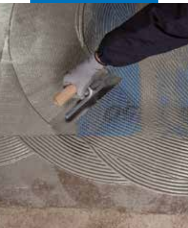
Zapracovanie sieťoviny Mapenet 150 do prvej vrstvy Mapelastíc Turbo
